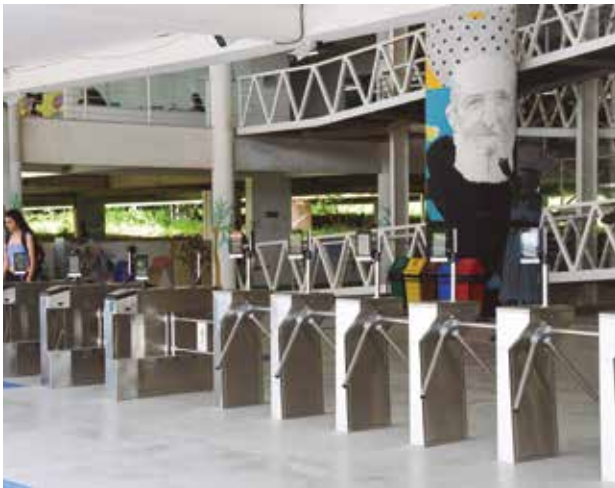
Equipamentos foram instalados no CCT e em laboratórios
